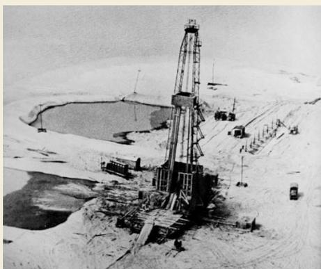
→ 29 мая 1965 года скважиной был вскрыт нефтегазонасыщенный разрез. Скважина дала более 300 куб. м в сутки с глубины 1700 метров.
